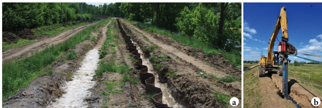
Obrázek 31: Ocelové štětovnice v tělese protipovodňové hráze (a); beranění plastových štětovnic (b).
