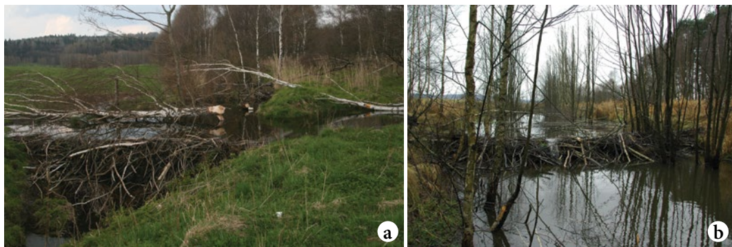
Obrázek 15: Bobří hráz a nad ní zadržovaná voda (a, b).
