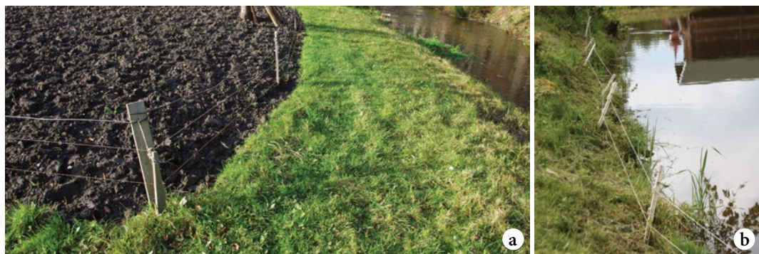
Obrázek 10: Správně instalovaný elektrický ohradník proti vstupu bobra na plochy.
