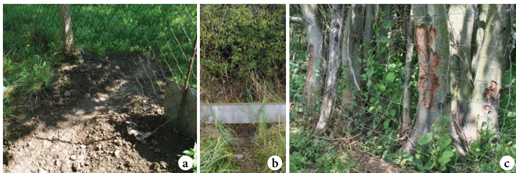
Obrázek 7: Nesprávně provedené oplocení porostu: pletivo není zapuštěno do země, bobr se podhrabal pod pletivem (a) i pod betonovým prahem (b); oplocení přiléhá ke dřevinám, bobr je poškodil okusem (c).
