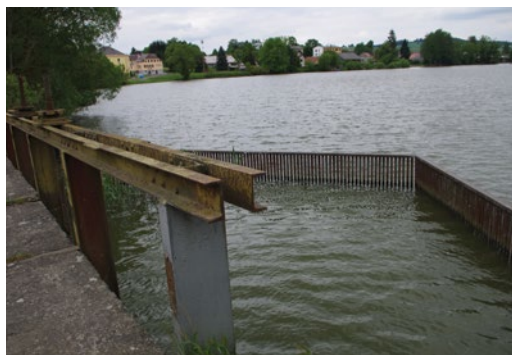
Obrázek 36: Česlová stěna před bezpečnostním přelivem.
