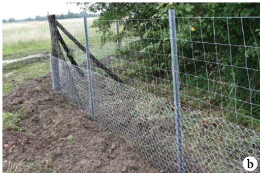
Obrázek 6: Oplocení porostu pletivem zapuštěným do země a ohnutým do tvaru písmene L ve fázi před zahrnutím vodorovné části zemínou (a); zesílení stávajícího oplocení přidáním pletiva, které musí být rovněž zapuštěno do země nebo při zemi ohnuto do tvaru L (b).
