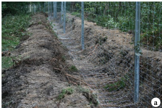
Obrázek 6: Oplocení porostu pletivem zapuštěným do země a ohnutým do tvaru písmene L ve fázi před zahrnutím vodorovné části zemínou (a); zesílení stávajícího oplocení přidáním pletiva, které musí být rovněž zapuštěno do země nebo při zemi ohnuto do tvaru L (b).
