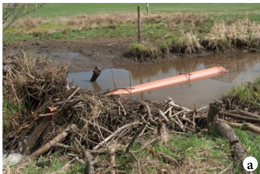
Obrázek 18: Drénování bobří hráze: trouba vložena do hráze s kolenem na nátoku a ochranným košem (a); detail nátoku trouby a ochranného koše (b).
